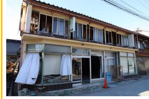
大変形による1層被害
