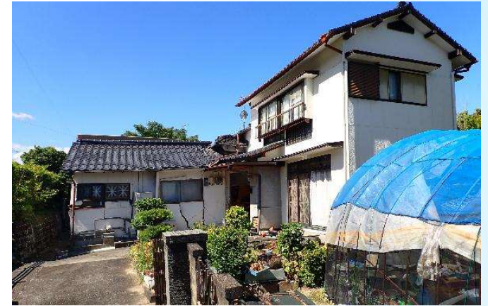
②地表断層、建物被害（宮原）
