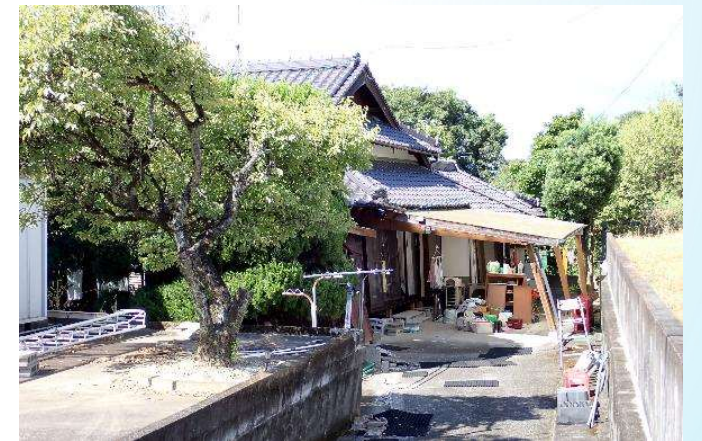
⑤地表断層、建物被害（興善寺町）
