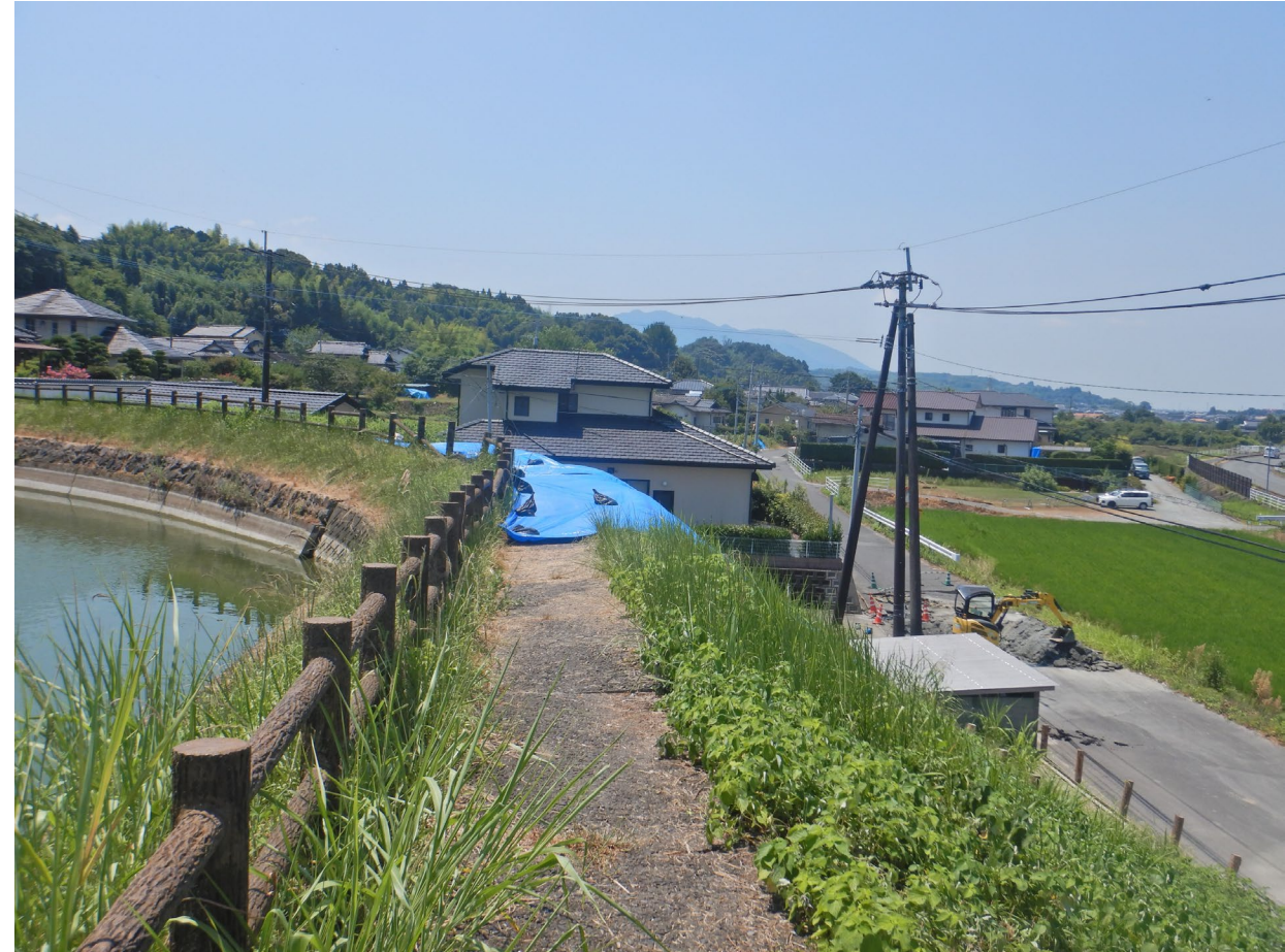
断層変位により亀裂の入った農業用ため池の堤体 (小川町)
