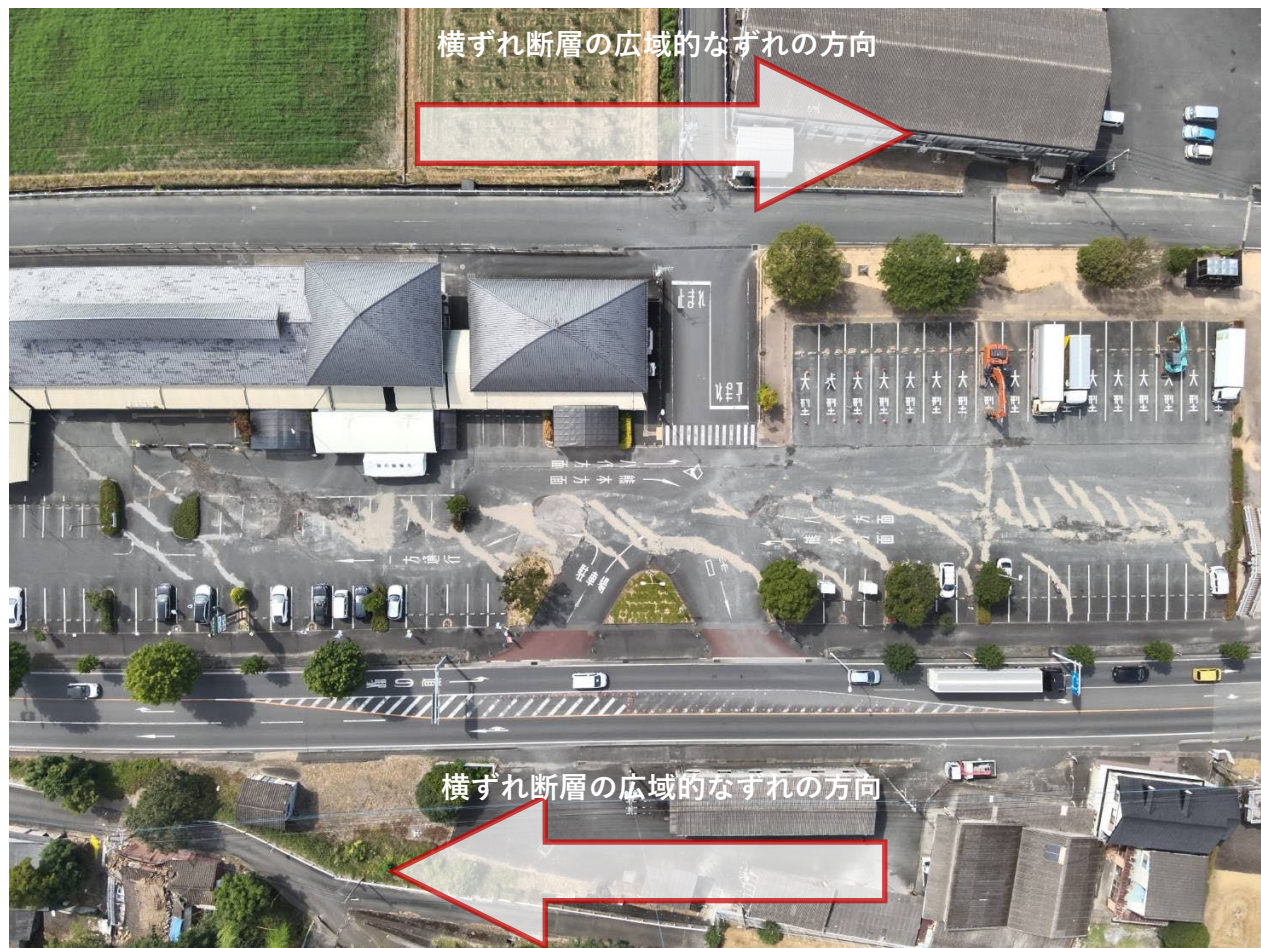
道の駅竜北 駐車場に生じた雁行状の亀裂
