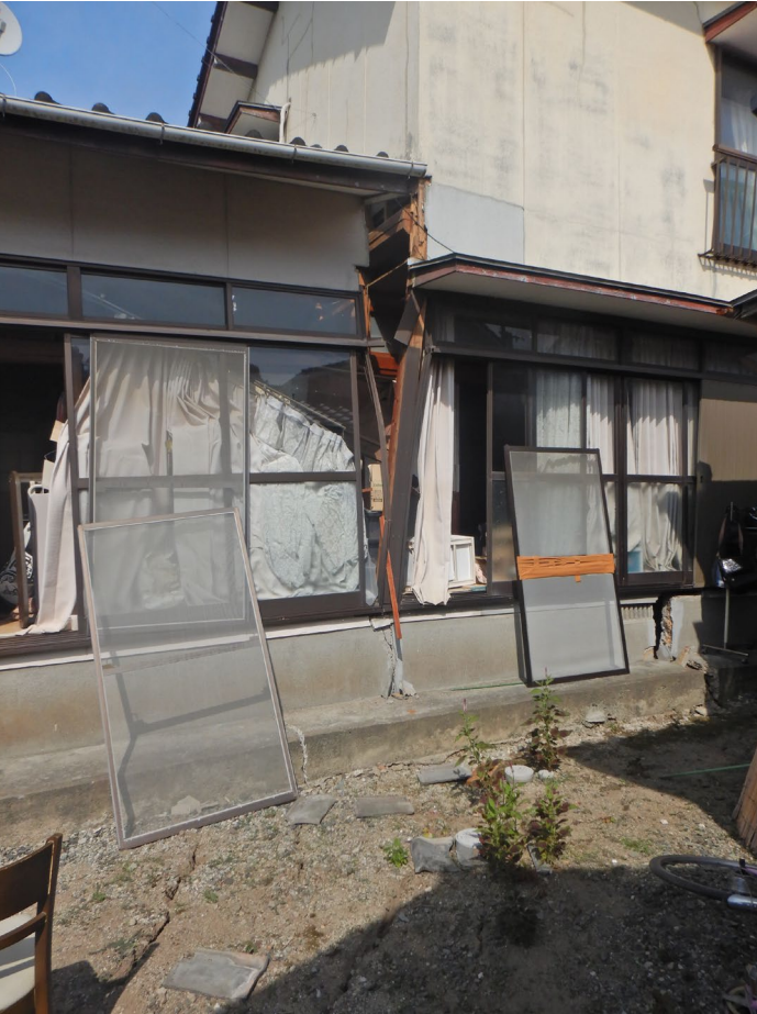
断層変位で被害を受けた家屋 (左：氷川町，右：小川町)
