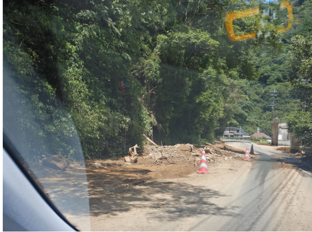
山間部の国道沿いにおける土砂流出（八代市東陽町）
