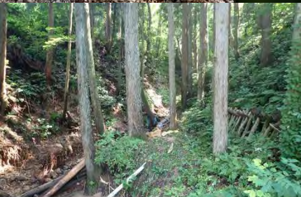
山中の土石流流下経路の様子
