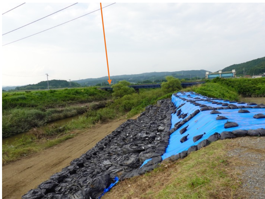
堤外地側の様子
