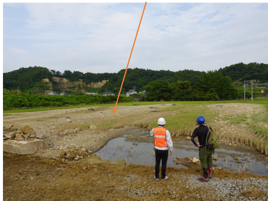
堤内地側の様子
