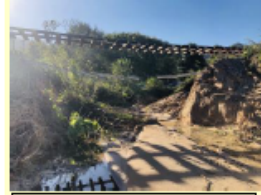
路盤流出 織笠～岩手船越間
