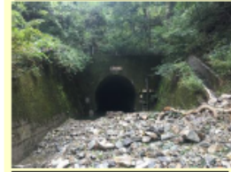
真崎トンネル 田老～摂待間
