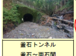
釜石トンネル 釜石～両石間
