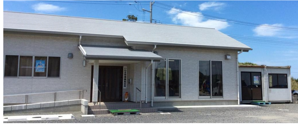
いわき市内の平屋建て地区集会所の事例
