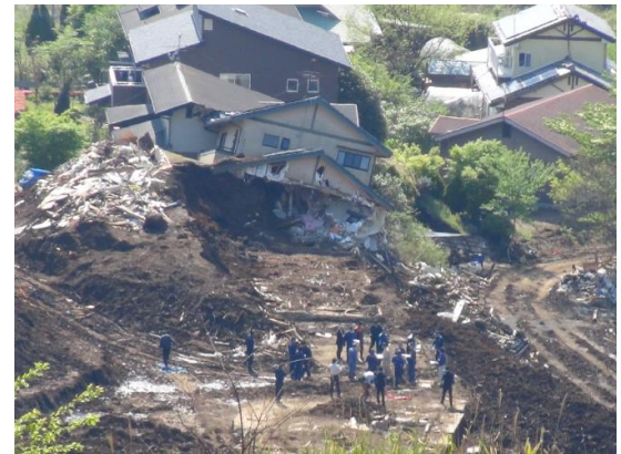
図 4 9 崩壊土砂による家屋被害
