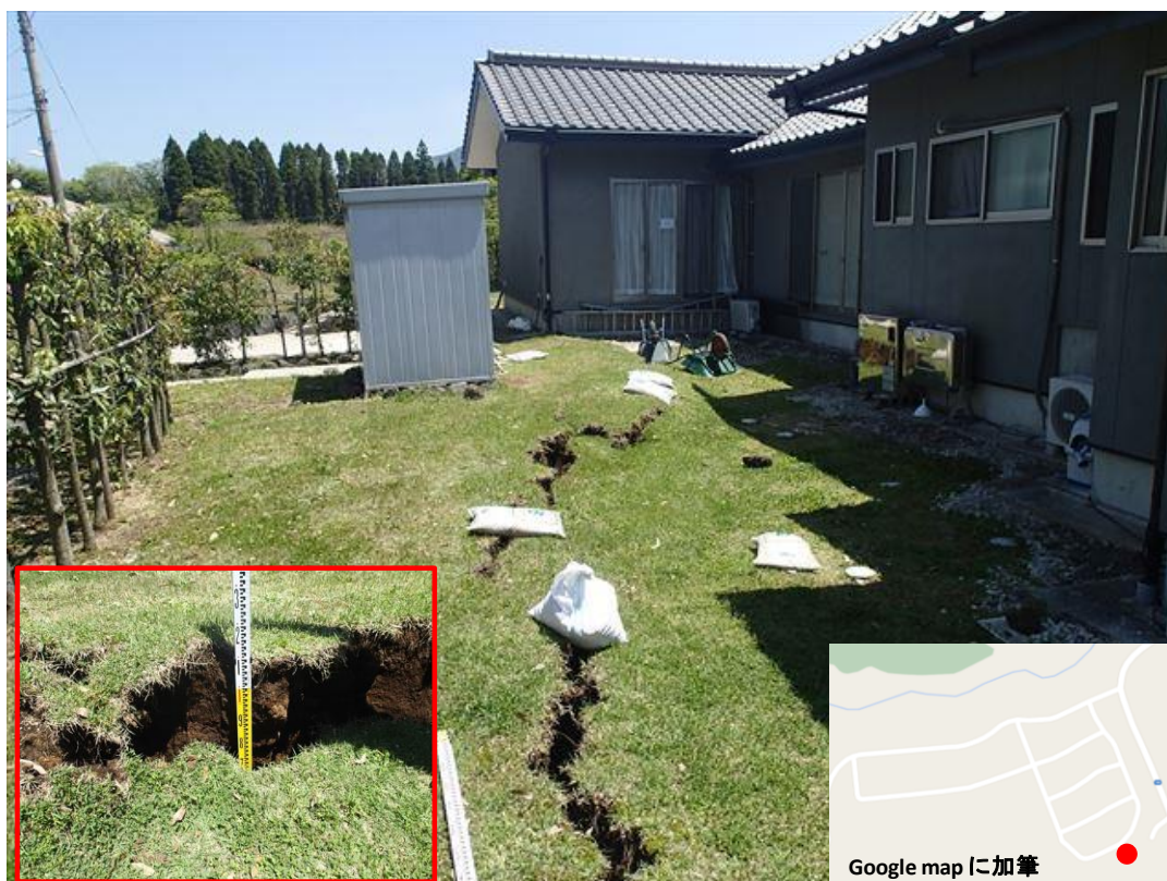
図 3 8 地盤変状と家屋被害 (その 4) (Google map に加筆)
