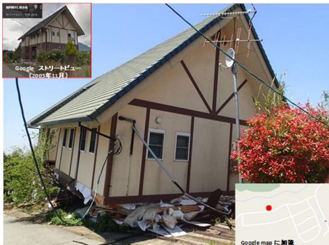
図 3 6 地盤変状と家屋被害（その 2）（Google map に加筆）
