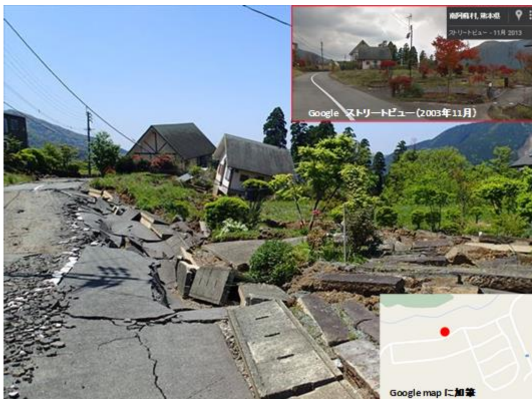
図 3 5 地盤変状と家屋被害（その 1）（Google map に加筆）
