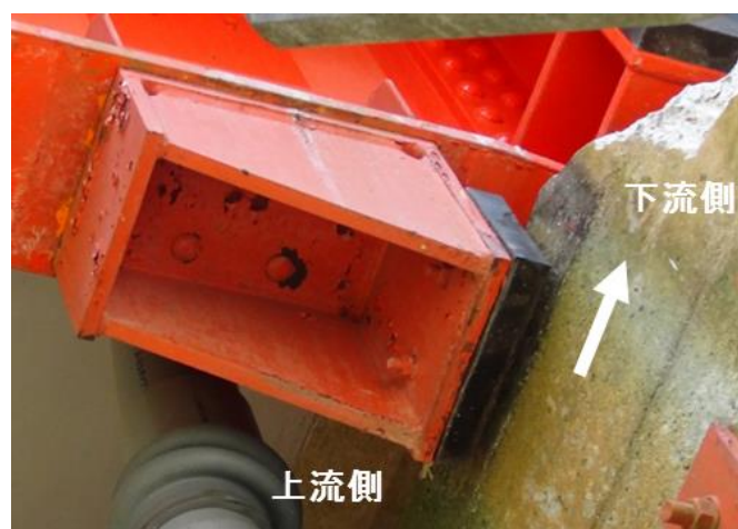
図 2 5 左岸下流側の緩衝材が橋台に衝突跡
