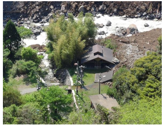
図 2 8 写真対象箇所②の様子
