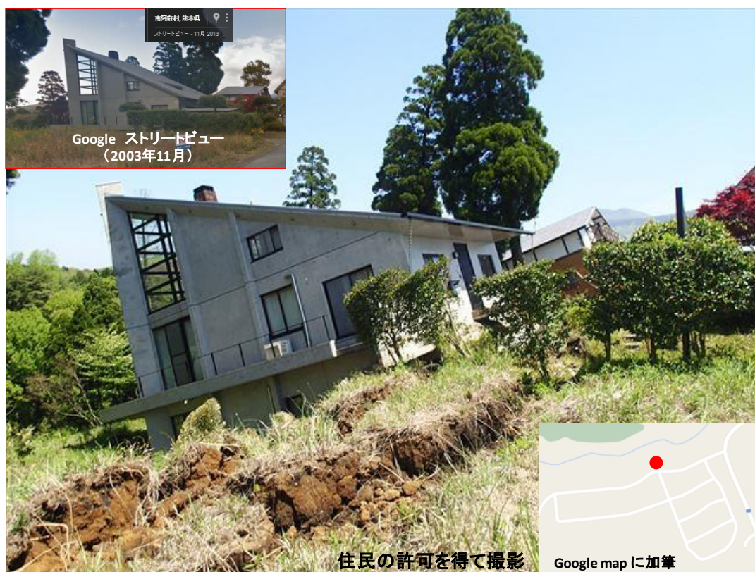
図 3 7 地盤変状と家屋被害 (その 3) (Google map に加筆)
