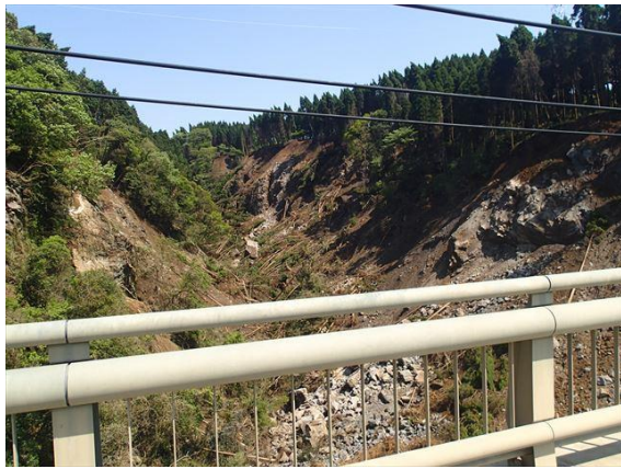
図 2 7 写真対象箇所①の様子
