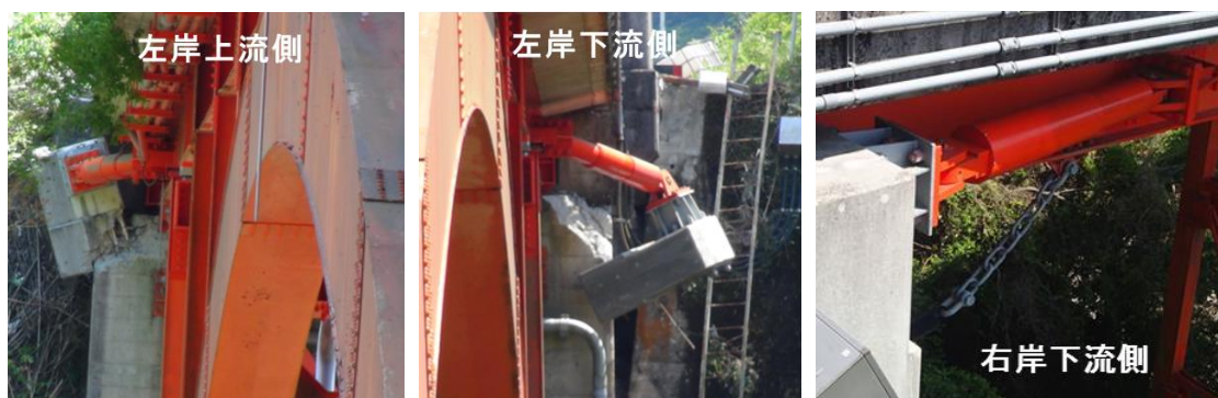
図 2 4 免振ダンパーの様子
