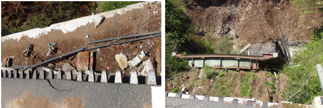
図9 左岸側（河陽側）の橋台と桁のジョイント部
