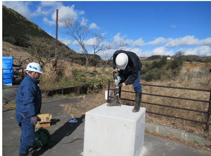
図 7 GB-SAR 設置用コンクリート台にアンカーボルト用の孔を掘削
