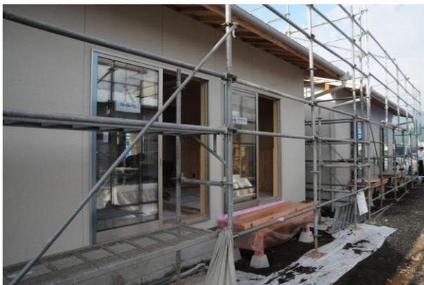
写真 1 施工中の木造応急仮設住宅
