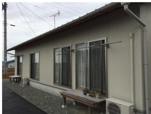
写真 10 今回建設された木造応急仮設住宅。本格的な RC の基礎が使われ、外壁も新建材で覆われている。
