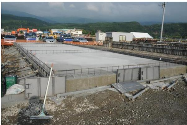
写真 2 施工中の木造応急仮設住宅の基礎
