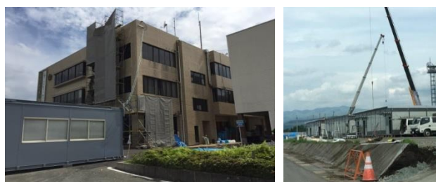
図8 修復中の益城町役場庁舎と建設中のプレハブ型仮設住宅
