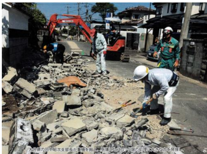
写真 11.2 油圧ショベルで傾いたブロック塀を撤去 (NPO 法人日本防災士会ホームページより)
