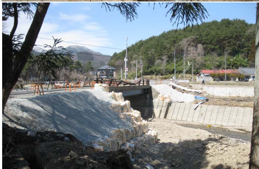
⑥ 約1km下流の橋梁部破損(流木による)
