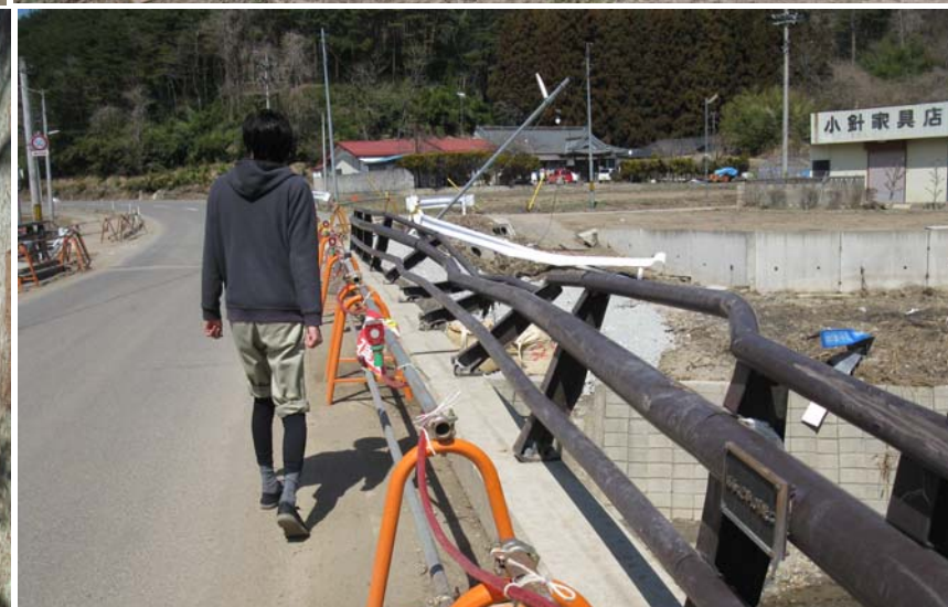
⑦ 約1km下流の橋梁部破損(流木による)
