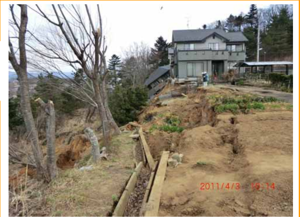
谷埋め盛土部の斜面崩壊
