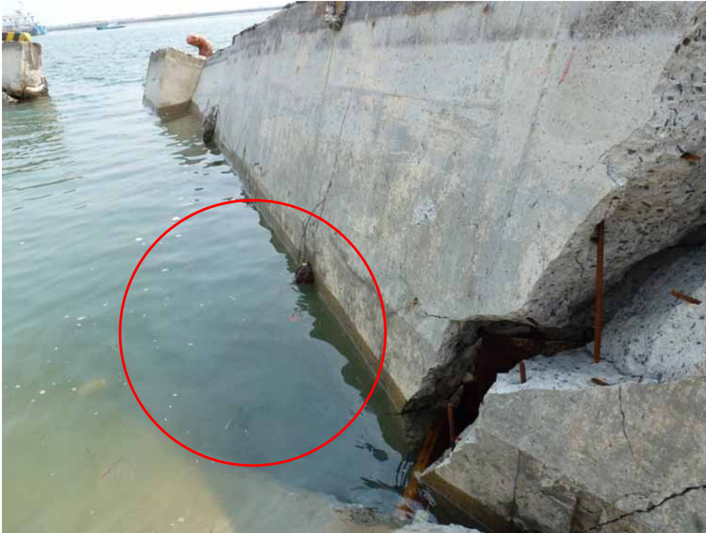
断裂したタイロッド
