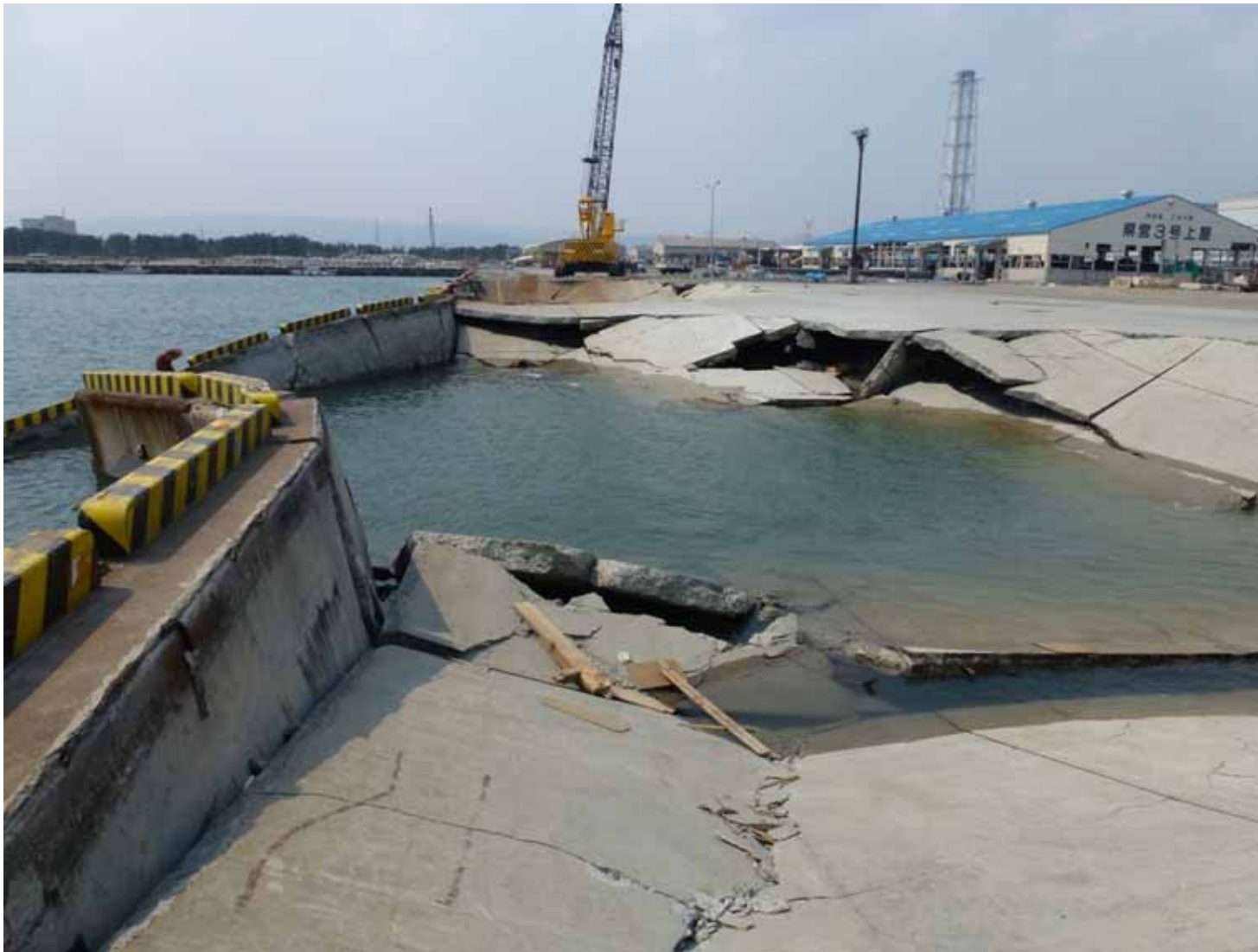
破壊された護岸（少なくとも6ヶ所の護岸の破壊 内4ヶ所は隣接）
