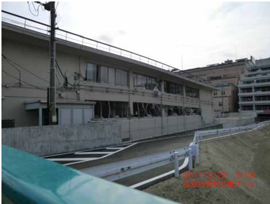
柱の座屈による一階部分の崩壊
