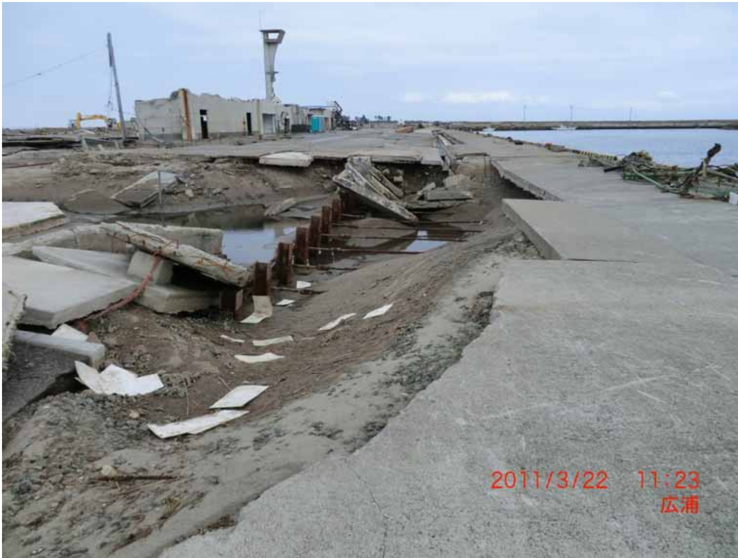
岸壁の控工頭部の露出(タイロッドは破断していない)
