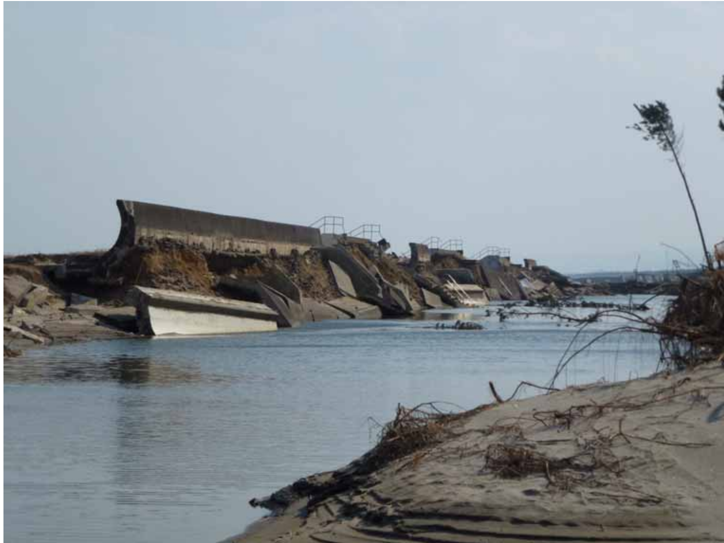
津波により破壊された防潮堤(7回?の津波を受けた地区)
