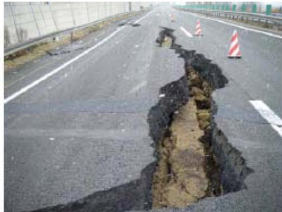
損傷状況 : 盛土区間における道路本体の崩落と、その進行に伴う路面の亀裂
