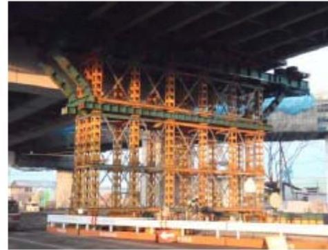
応急復旧状況 : 鋼材の仮支柱を設置し、ジャッキアップ・水平移動し本来の位置に戻すとともに、損傷部位を補強。
