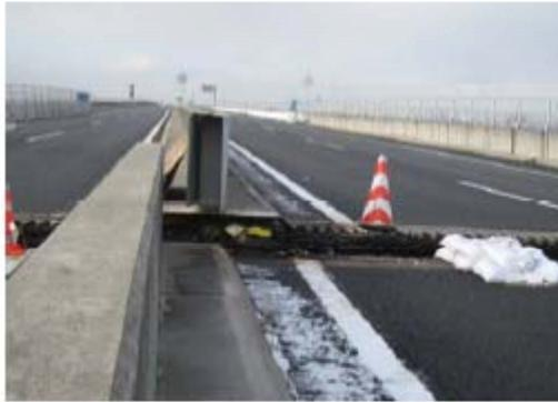
損傷状況 : 橋脚上に設置した、橋桁を支えている支承が損傷し、鉛直方向、水平方向にずれている。
