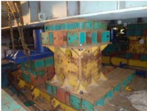
応急復旧状況 : 破断した支承の代わりに鋼材を設置し、橋脚と橋桁を固定。
