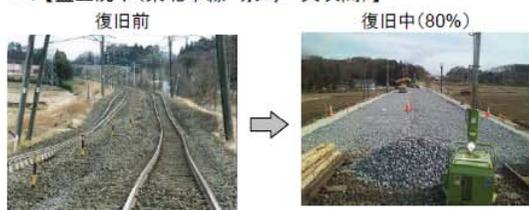
オ.【土留壁倒壊・盛土流失(東北貨物線 長町～宮城野間)】
