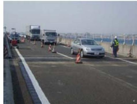
応急復旧状況 : 損傷した伸縮装置を撤去し舗装施工。
