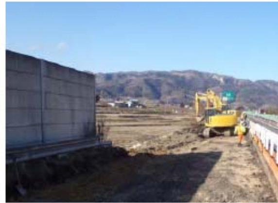
応急復旧状況 : 道路本体の損傷した盛土部分を取り除き
