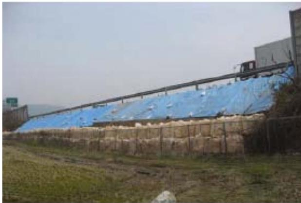
応急復旧完了 : 道路本体の崩落部を大型土のう（直径1.2m）で押さえ安定させる
