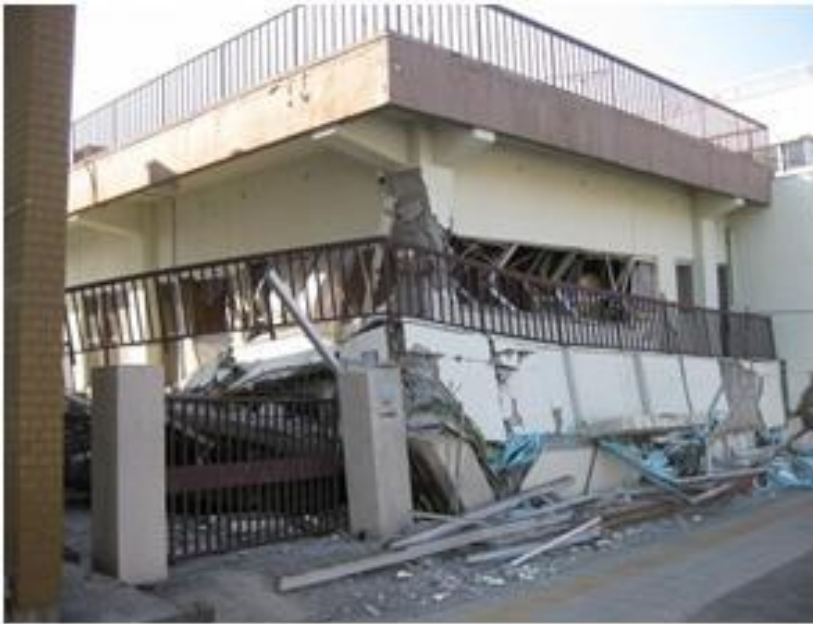
卸町2丁目のRC造2階建て建物の倒壊
