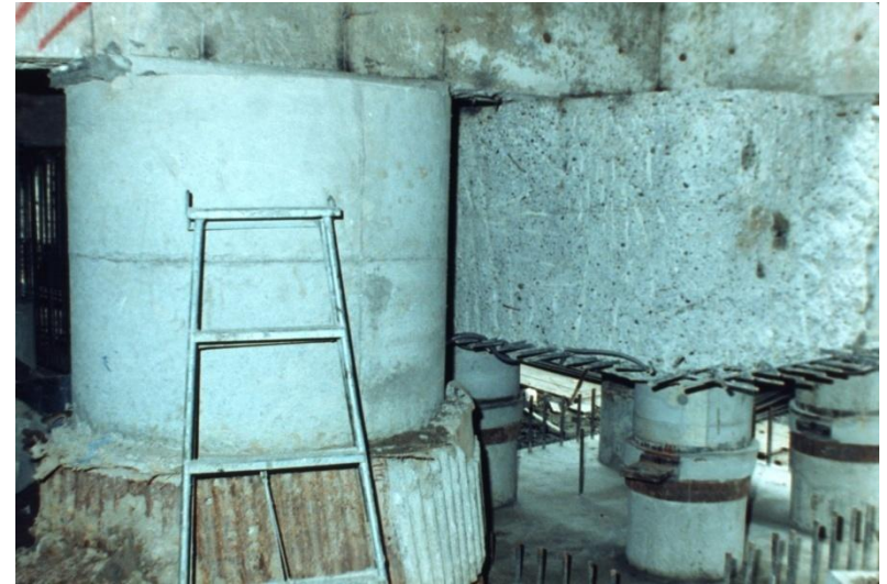
増設基礎梁と増設ピア による耐震補強
