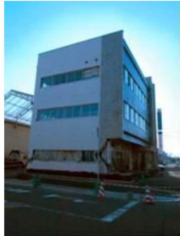
卸町3丁目におけるRC造3階建て建物の倒壊
