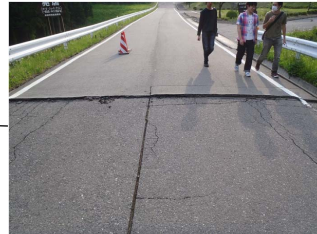
管理道路の圧縮亀裂
