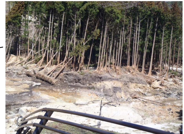
ダム直下土砂浸食樹林の流出
