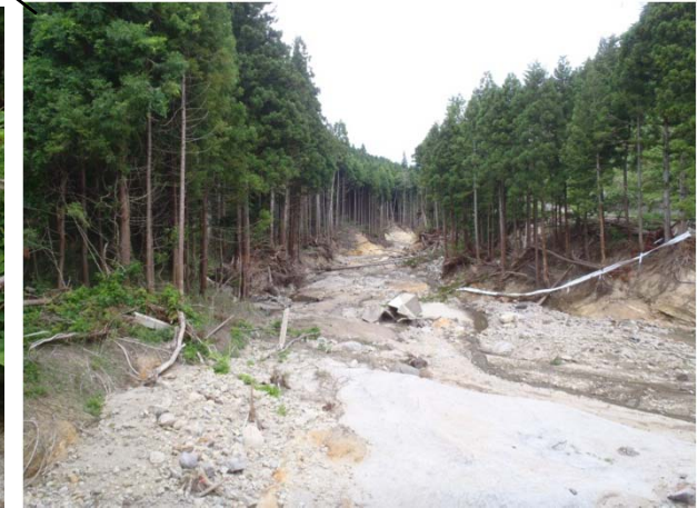
ダム下流の土砂浸食状況
