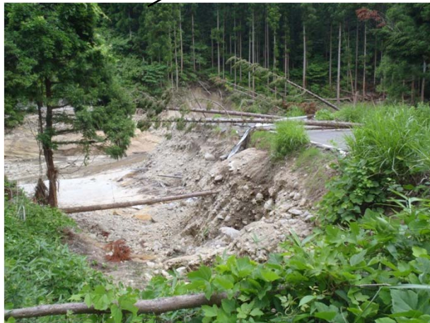
ダム下流の市道の流木
