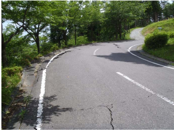
斜面崩落に伴う市道クラック
