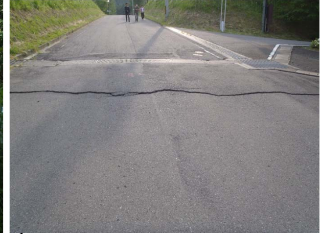
管理道路の圧縮亀裂
