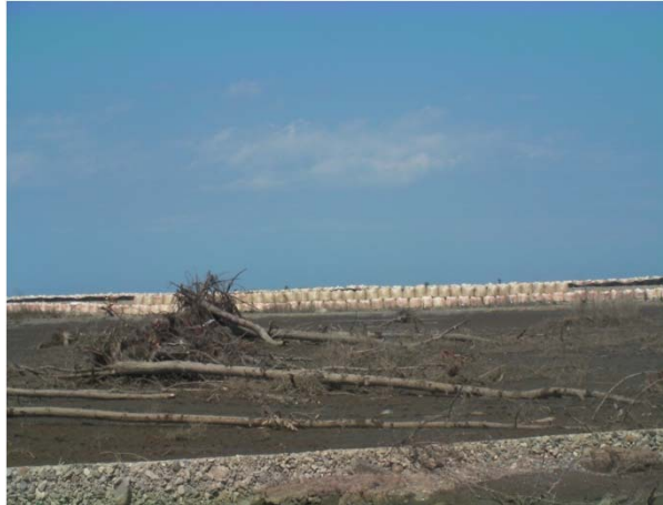
①松川浦破堤箇所
