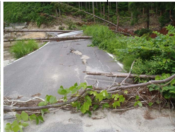
ダム下流の市道の流木
