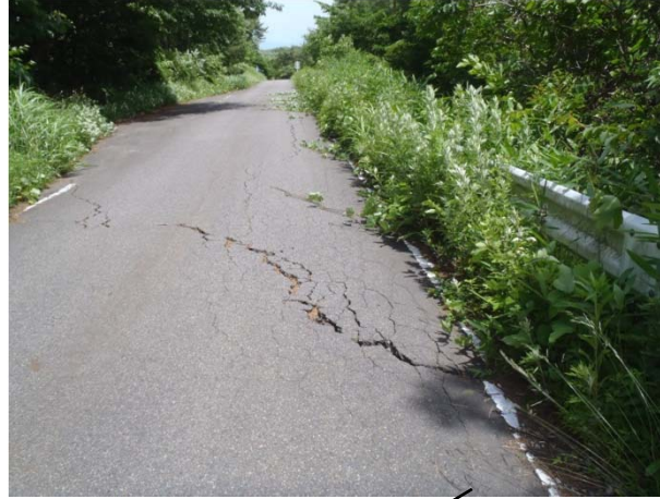
斜面崩落に伴う市道クラック
