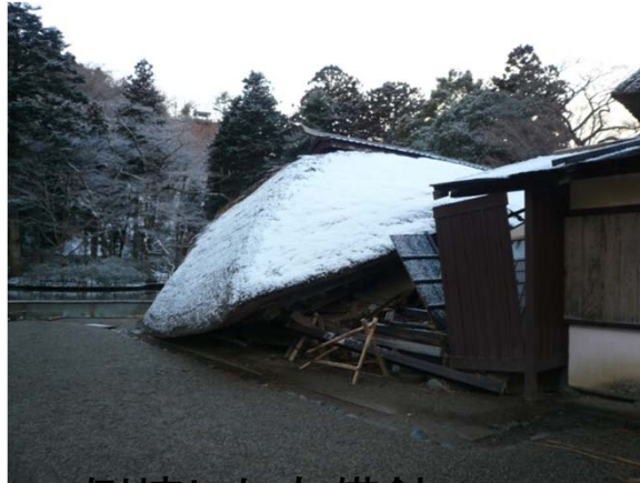
倒壊した有備館
