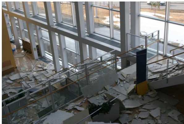
庁舎の天井落下 (三本木庁舎)
