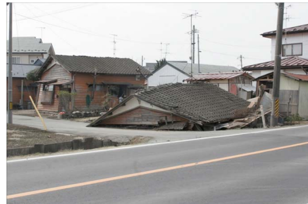
倒壊した木造家屋 (田尻地区)
