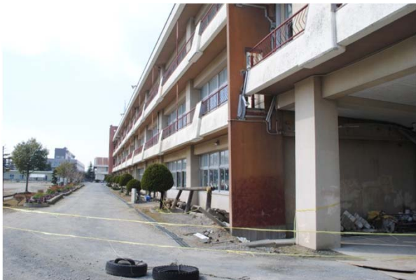
沈下し傾斜した学校校舎 (古川東中)
