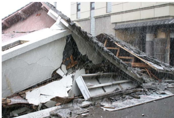
倒壊した店舗 (台町)
