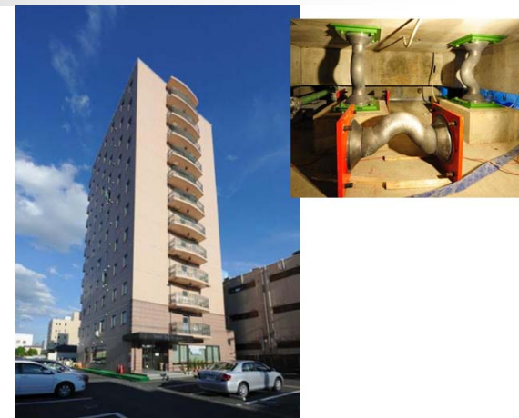
免震構造建物の被害 日経アーキテクチャより
