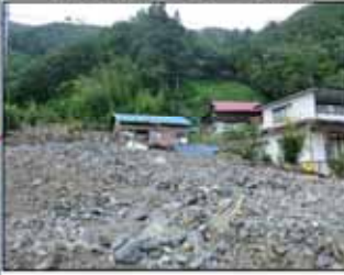
岩泉町浅内地区の土石流
