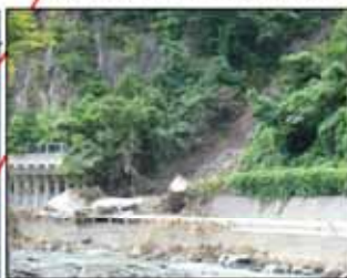
岩泉町安家地区の崩壊
