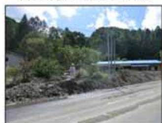
岩泉町内ノ沢地区の土石流
