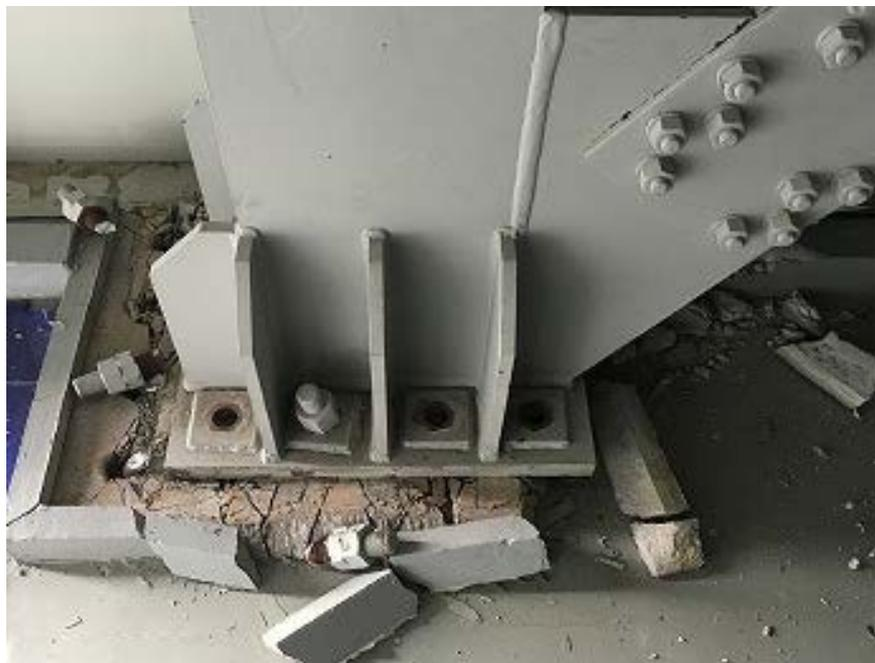
固定ボルト破断の写真
