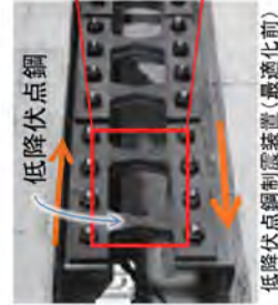
最適な材料配置を算出し、エネルギー吸収性能を改善した
