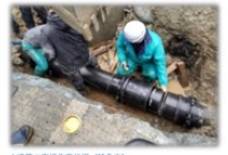
水道管の復旧作業状況 (能登市) (写真) 令和6年能登半島地震復旧・復興支援本部 (第4回) 資料
