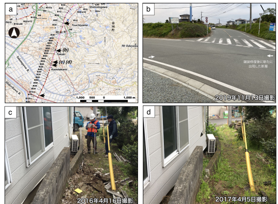
a) 余効すべりが確認された地点(矢印の地点)。b) 地震後に修復された路面に出現した亀裂群。c) 地震直後のブロック塀の変位。d) 1年後のブロック塀の変位。ブロック塀が剥離しているのがわかる。
