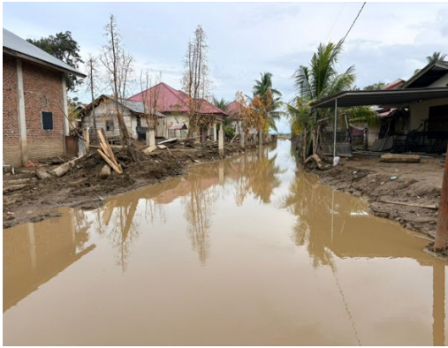
北アチェ州セニヤールから2か月後、 ピディ・ジャヤで浸水した家屋
