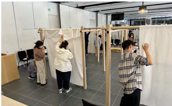
間仕切りシステムの組み立て
