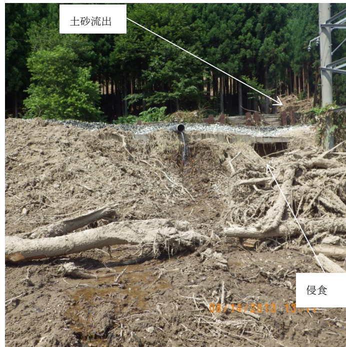
図-27 岩手県雫石田沢湖線（秋田新幹線）での土砂崩れの様子
