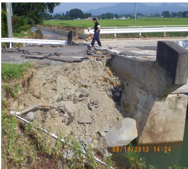
図-19 雫石町御明神地区四ツ谷橋の被害状況と浸食された左岸の様子
