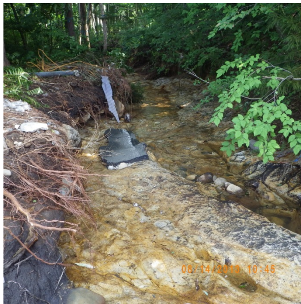
図-25 道路アスファルトが排水路上で数メートル流下している様子
