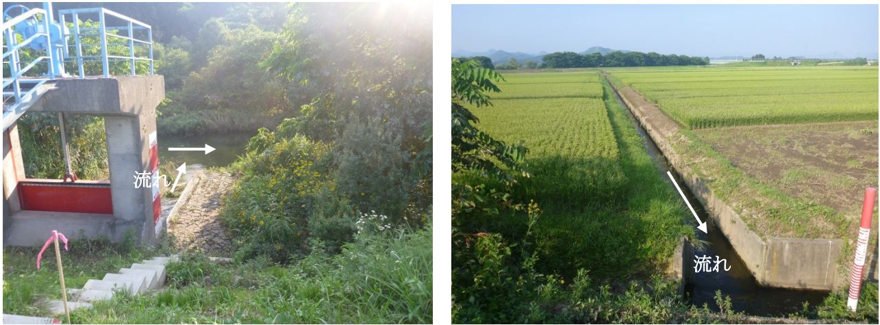
図-31 引欠川の破堤箇所の上流に位置する水田からの排水路。右は引欠川の排水路から水田側を撮影
