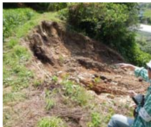
崩壊部分の様子
