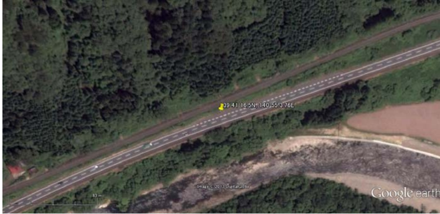
図-26 岩手県雫石田沢湖線（秋田新幹線）での土砂崩れ調査位置（Google earth より）
