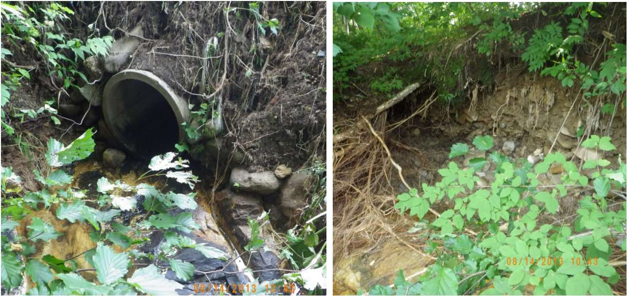
図-24 道路浸食箇所側方下部にある暗渠の様子（左）。右写真は暗渠排出口前方の浸食の様子
