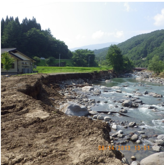
図-21 竜川に残る洪水痕跡の様子と右岸の浸食および倒木の様子
