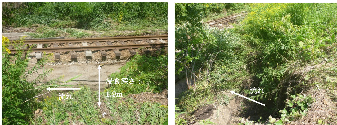
図-35 鹿角市を走る JR 花輪線における線路横の浸食の様子（左）。右は排水路を上部から撮影
