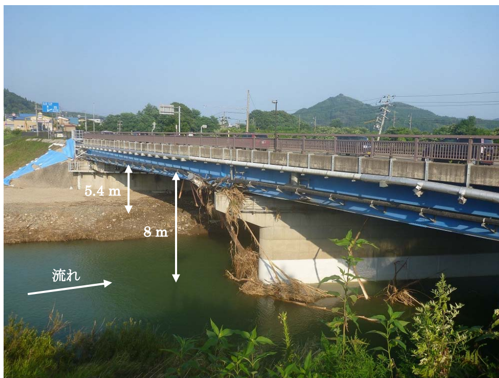
図-29 洪水痕跡が残る秋田県大館市早口川下流の早口橋の様子
