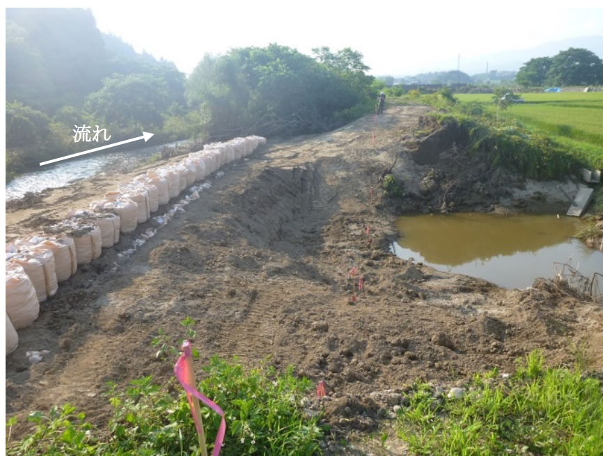
図-30 引欠川の破堤状況とそれを土嚢で応急対応する様子
