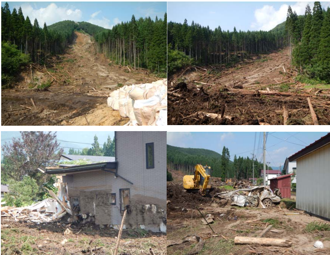
図-9 被災現場の様子
