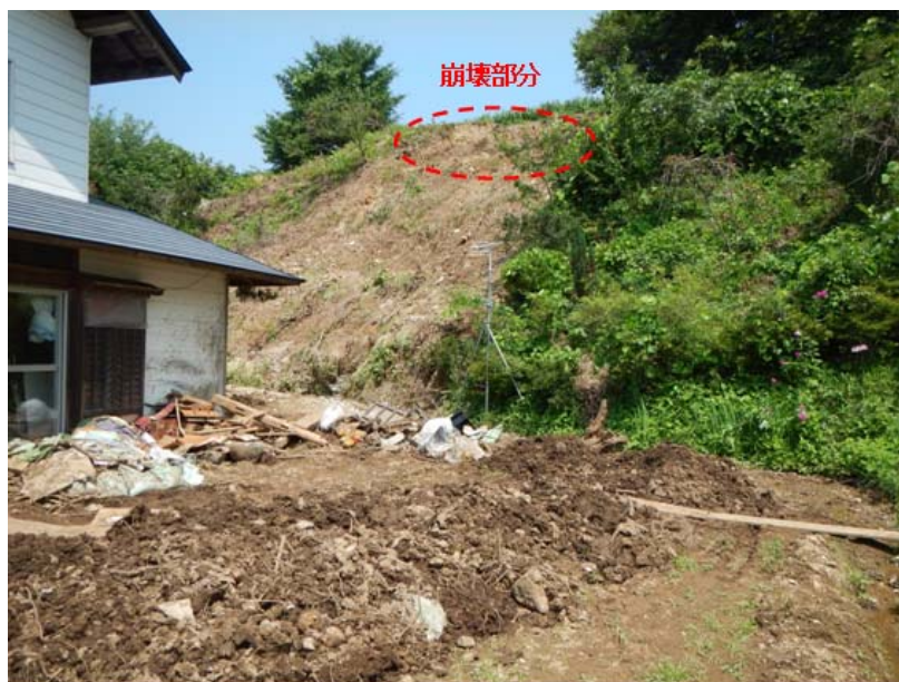
民家裏の斜面と崩壊部分
