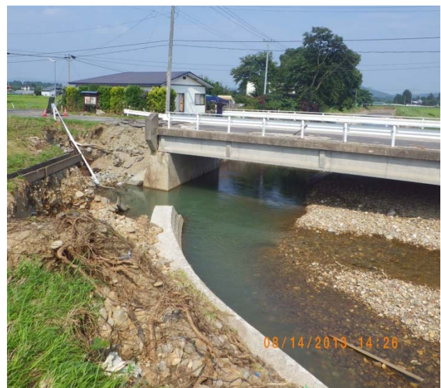
図-19 雫石町御明神地区四ツ谷橋の被害状況と浸食された左岸の様子
