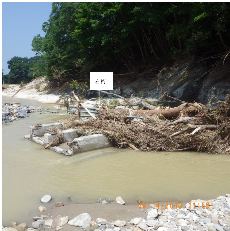
図-17 橋の下流側の河川中央から撮影した写真（下流向き）
