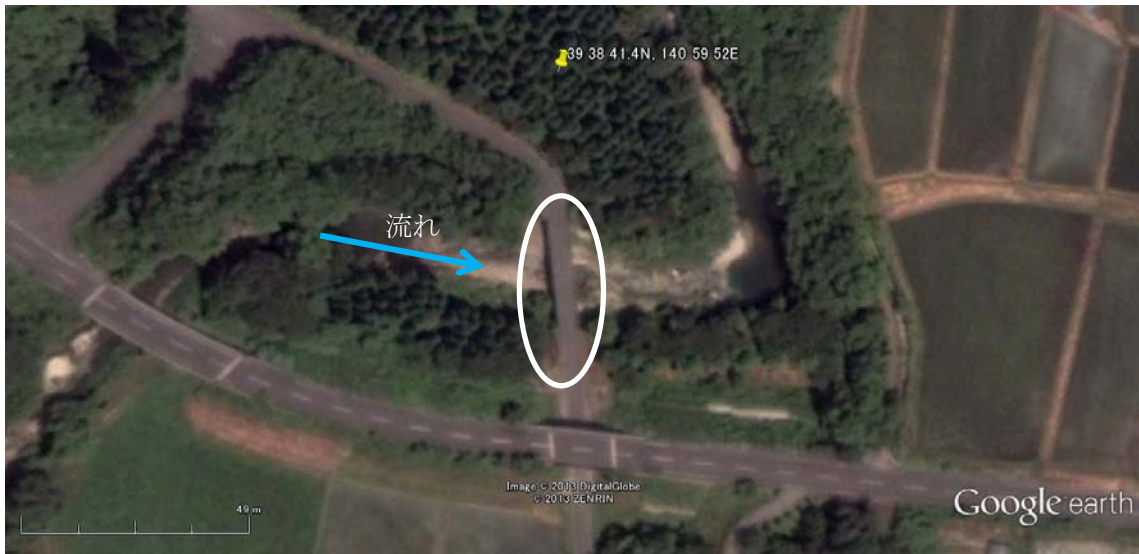
図-11 崩落した矢櫃橋の位置と河川の状況 (Google earth に加筆)
