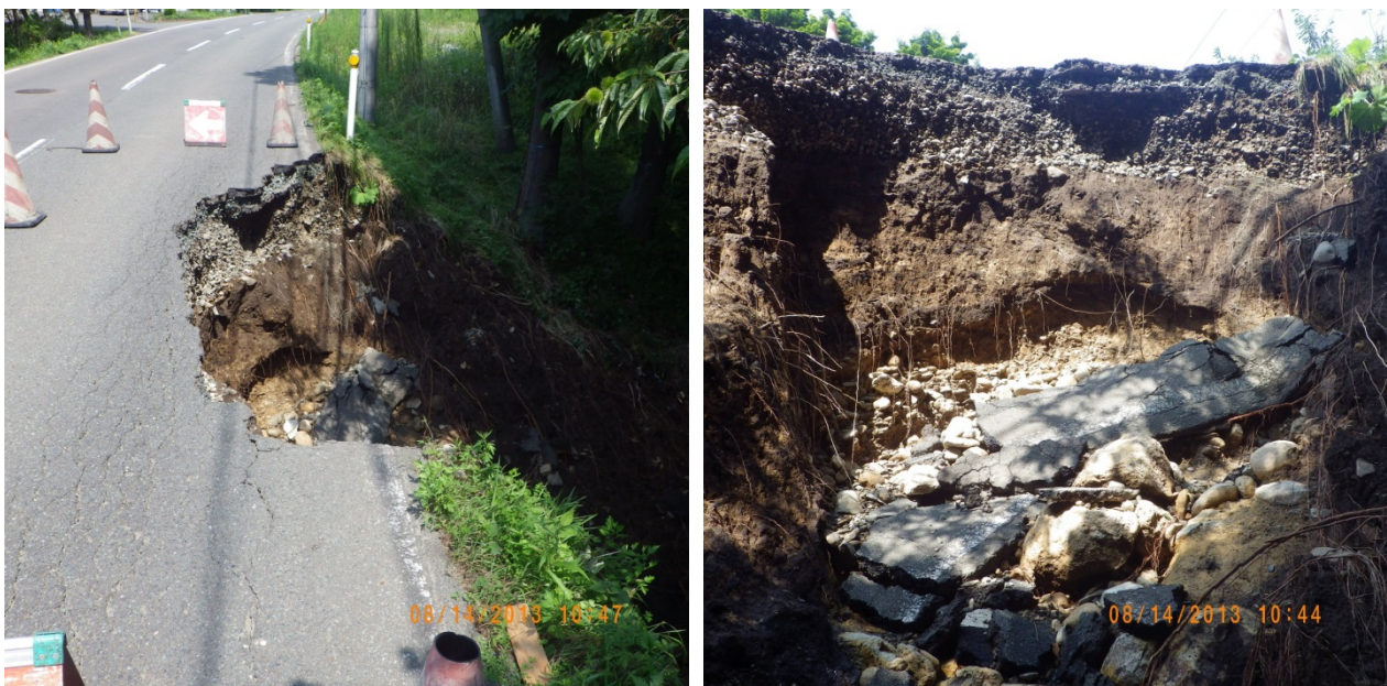
図-23 道路の侵食の様子。右写真は浸食された道路の側面。浸食が基盤岩にまで到達していた
