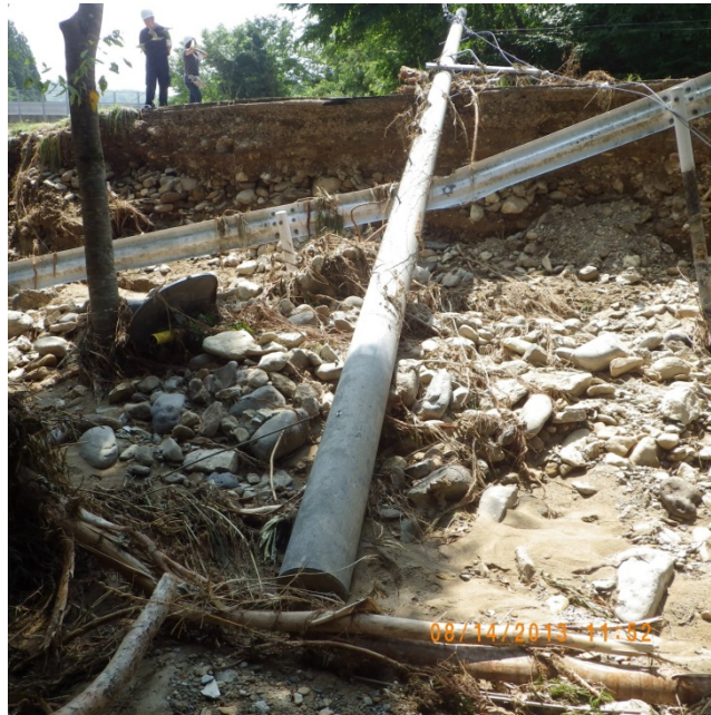
図-13 左岸側の氾濫原の堆積物とがれきおよび電柱基盤の洗掘の様子
