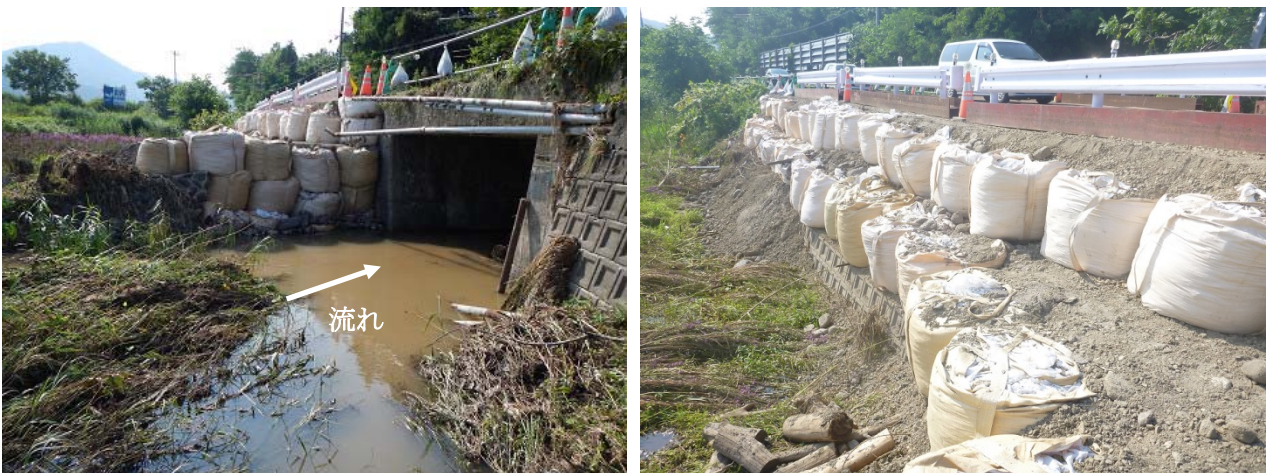
図-34 鹿角市を走る国道 103 号線における道路浸食・崩落箇所を土嚢で応急復旧した様子
