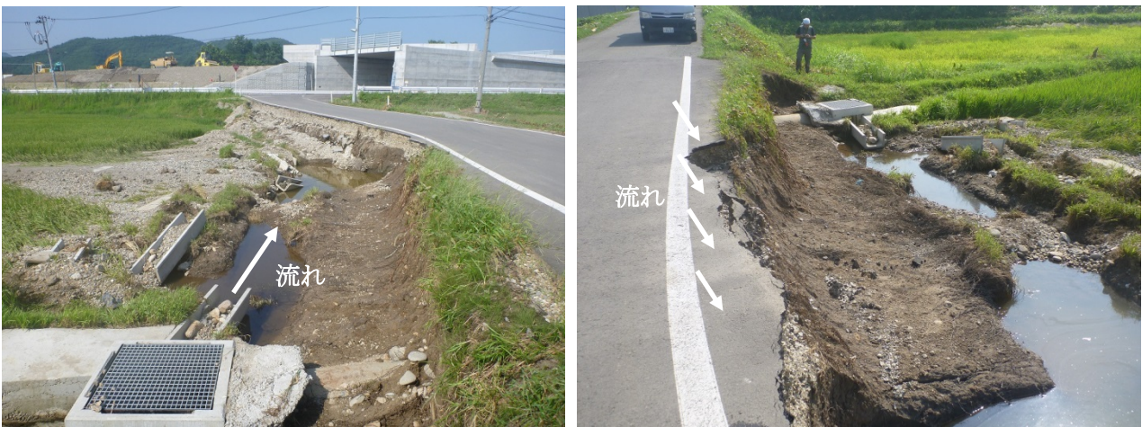
図-33 鹿角市を走る 103 号線の側道における道路浸食の様子
