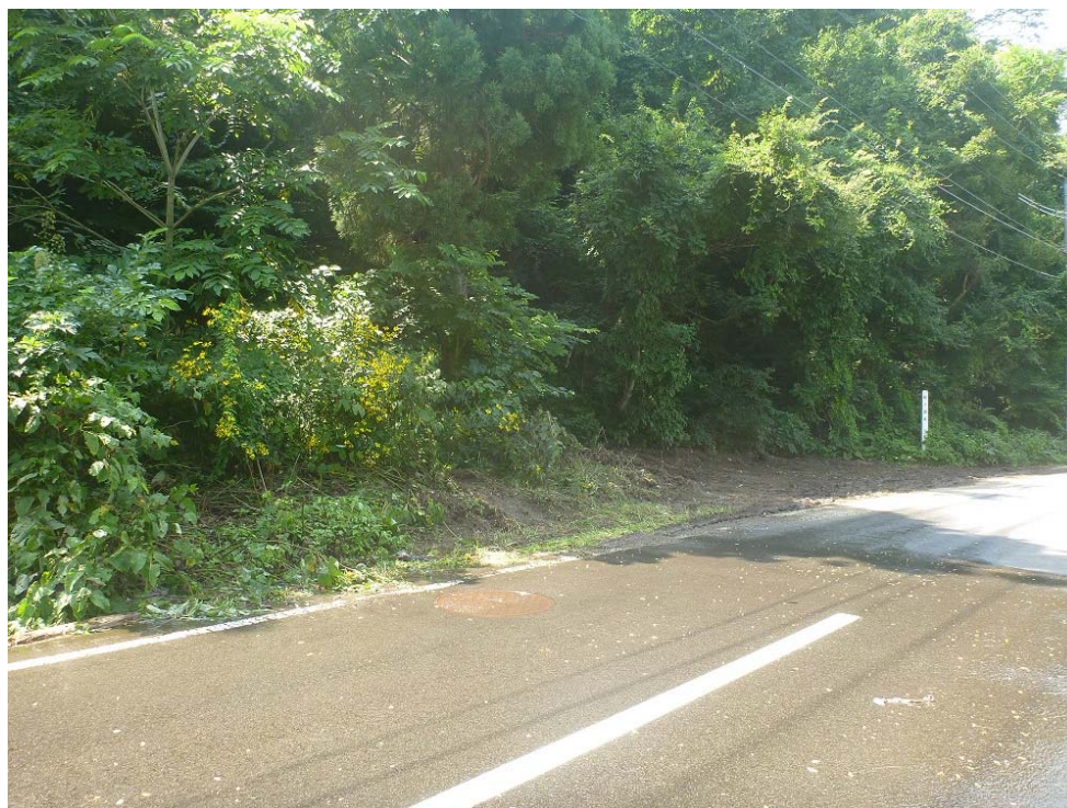
図-36 JR 花輪線浸食箇所の山腹側の状況。地表面流が線路に向けて流出している
